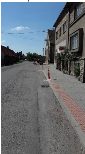
montáž sloupků – ul. Švermovská
